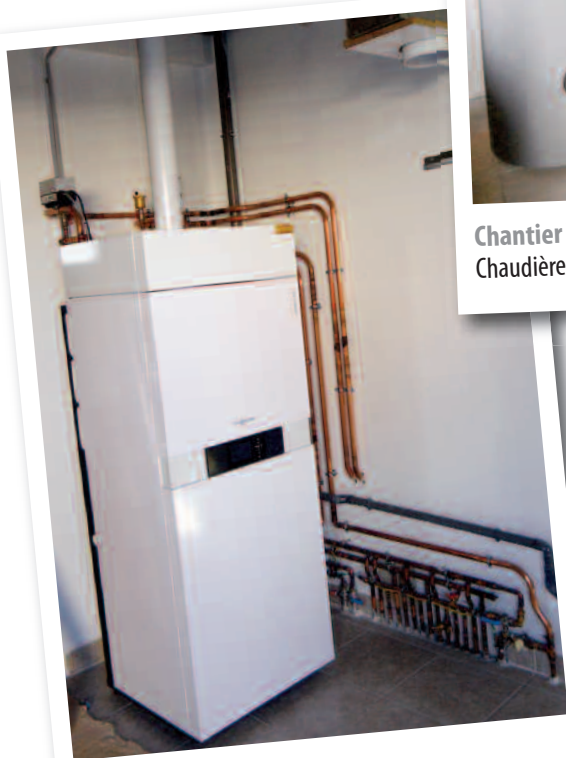
Chantier Peigney 52200 Chaudière gaz à condensation
