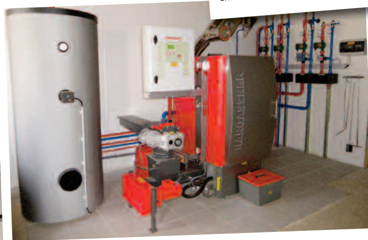
Chantier Villiers-sur-Suize 52210 Chaudière bois déchiqueté avec production d'eau chaude
