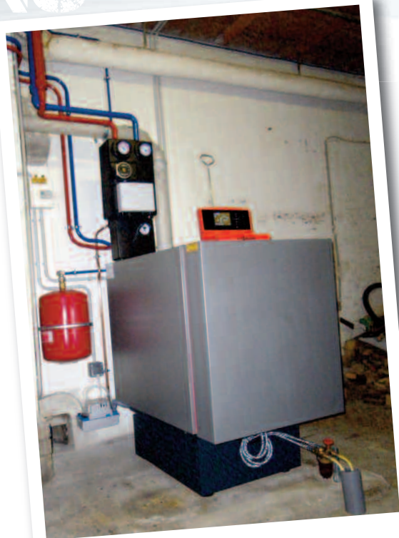
Chantier Vitrey-sur-Mance 70500 Chaudière fioul à condensation
