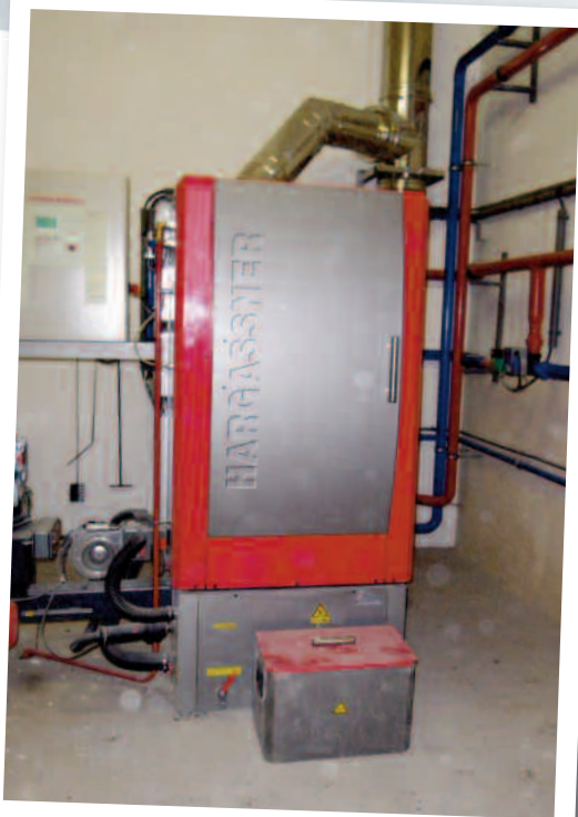
Chantier Entr'in 52 Chaudière bois déchiqueté 100 Kw
